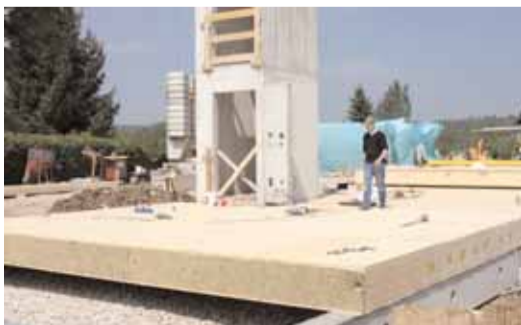
End-Montage der vorgefertigten Boden-Platten auf der Baustelle.
