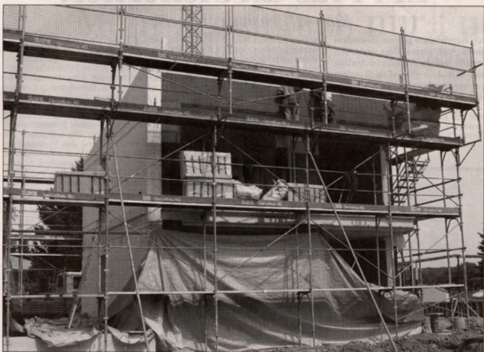
Noch ist das Haus im Bau, aber schon ist die Fensterfront auf der Südseite des Hauses erkennbar. Über dreifachverglaste Fensterscheiben wird damit Passivenergie erzeugt. Bild zvg
